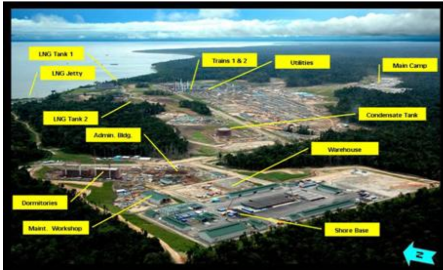
Tangguh LNG Facilities Overview
