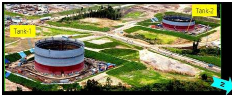
LNG Tank 1 and Tank 2
