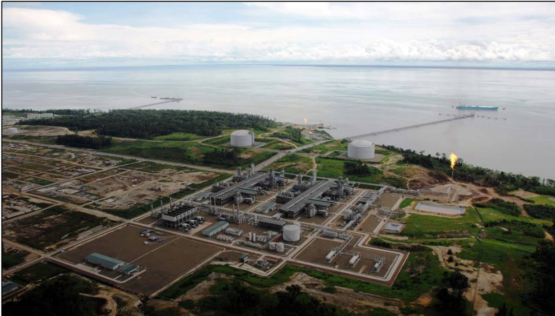
Tangguh LNG Facilities Overview
