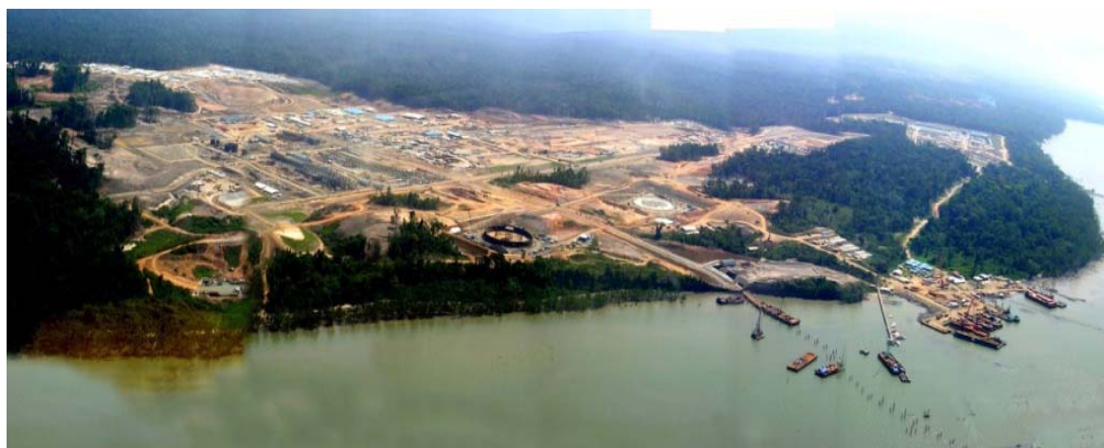
LNG Site Overall View
