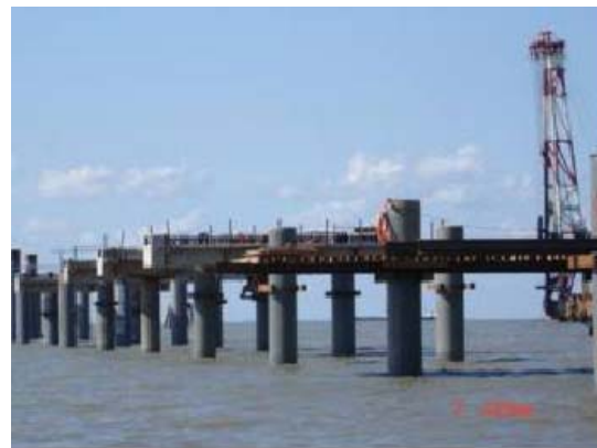
LNG Jetty Piling
