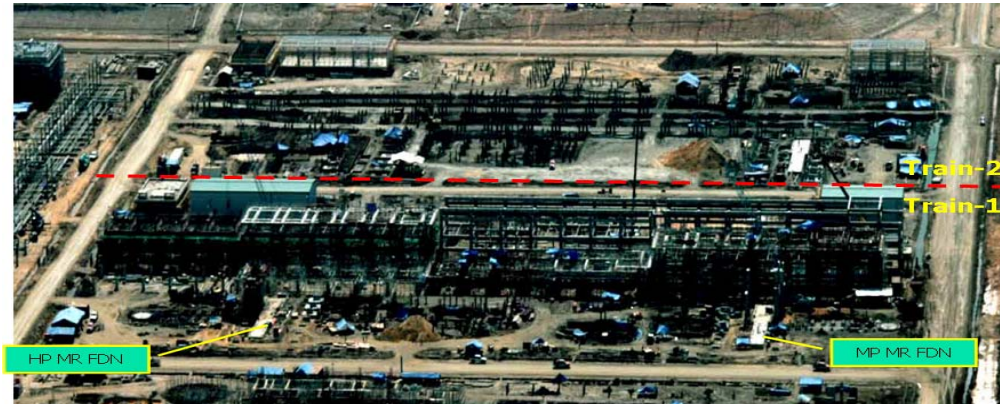
LNG Train 1 and 2
